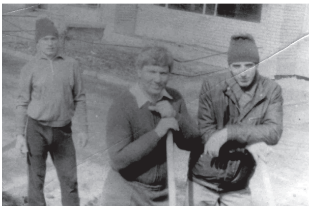
Преподаватели кафедры на строительстве лыжной базы: Александр Емельянович Вильховой, Виктор Петрович Мишин, Иван Филиппович Воронков, 1977 г.
